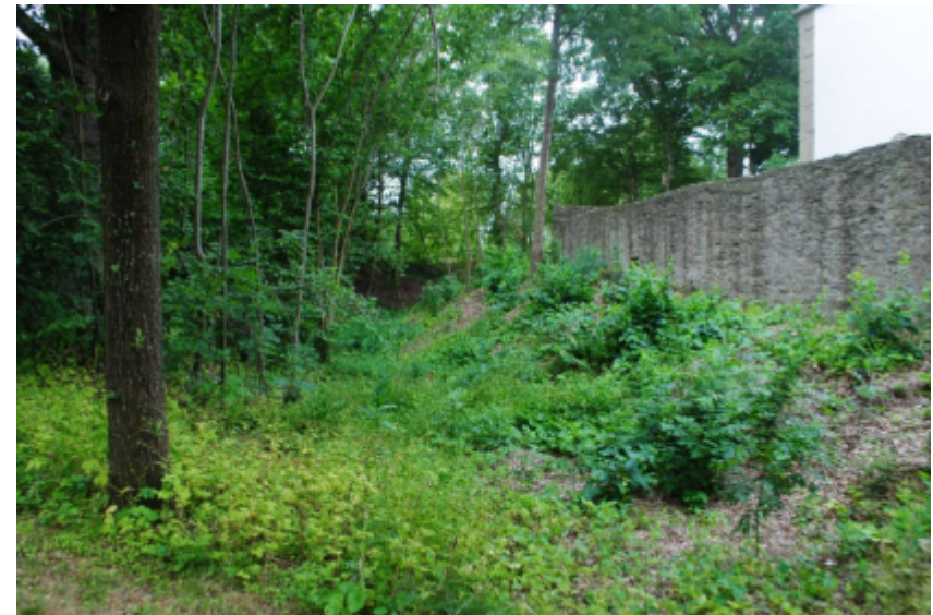
Abb. 032 – Wall mit Graben
