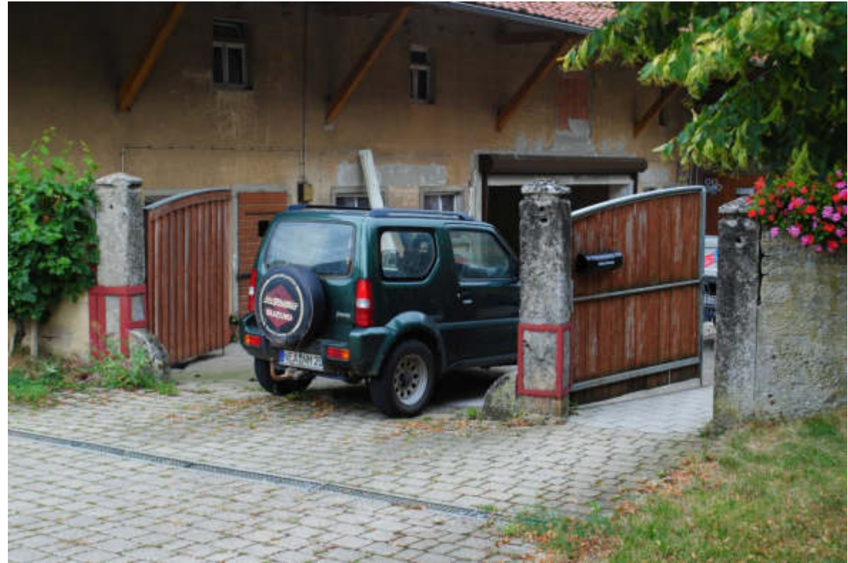
Abb. 060 – Torpfosten der Hofzufahrt
