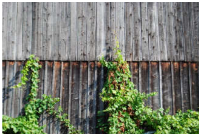
Abb. 087 – Sparschalung mit Deckleisten.
