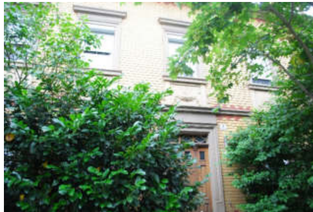
Abb. 055 – Fensterrahmen mit Verdachung
