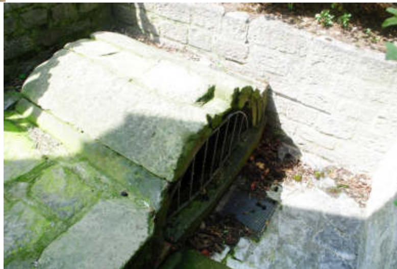
Abb. 174 – Brunnenhaus mit Vergitterung - Frontansicht
