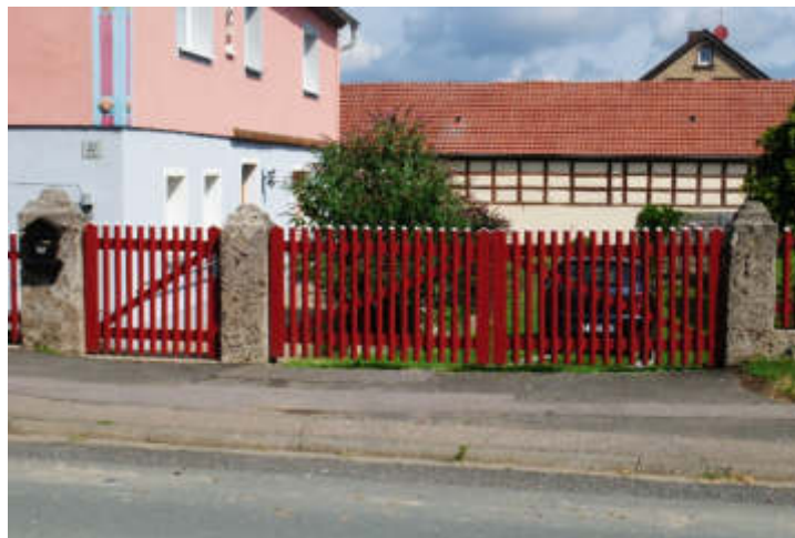
Abb. 136 – Torpfosten der Hofzufahrt
