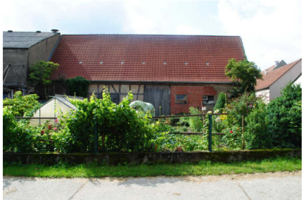
Abb. 111 – Nordansicht der Scheune
