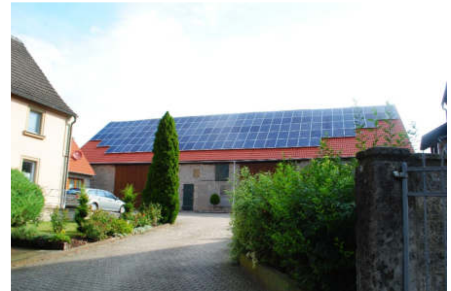
Abb. 074 – Querstehende Scheune gegen Osten
