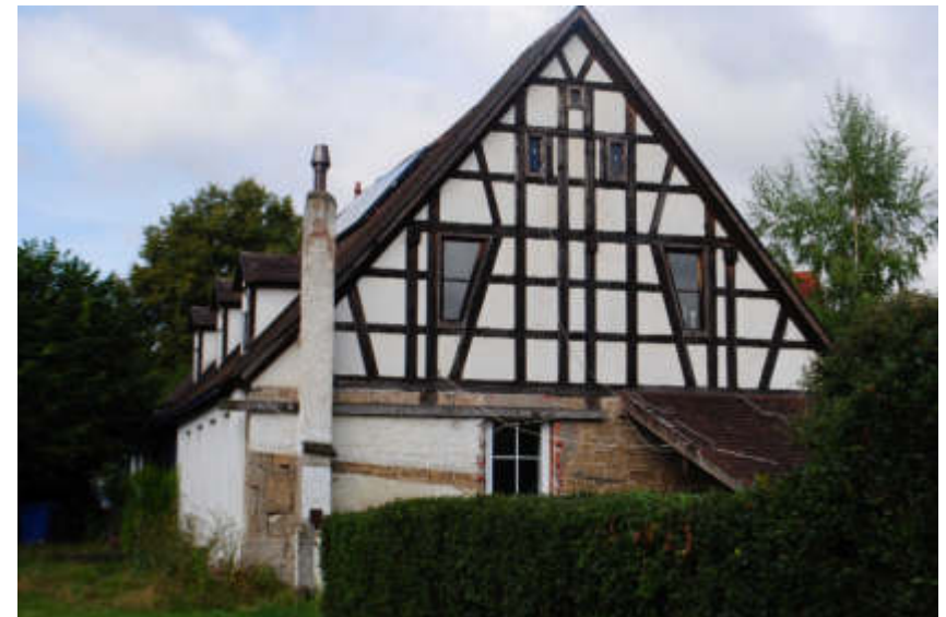
Abb. 102 – Ostgiebel – Fachwerk teilweise erneuert
