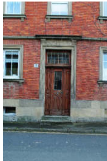
Abb. 169 – Portal mit Gewände
