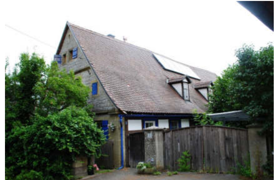
Abb. 029 – Südwestansicht – Westgiebel massiv
