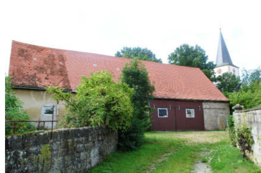
Abb. 100 – Historischer Mauerzug und Scheunengebäude
