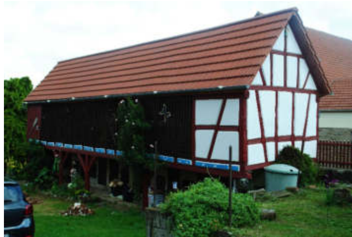
Abb. 160 – Nebengebäude Holzlege über Ställen, Gewölbe
