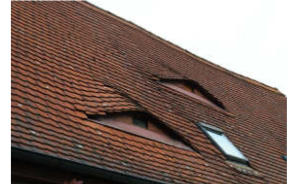
Abb. 027 – Biberschwanzdeckung mit Fledermausgauben
