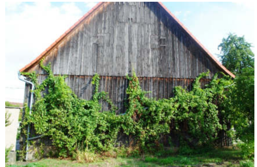
Abb. 086 – Südgiebel mit Lärchenschalung
