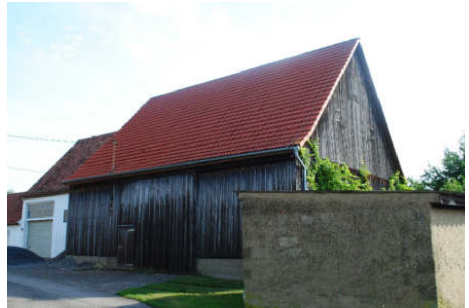
Abb. 085 – Scheune mit Brettschalung - Südwestansicht
