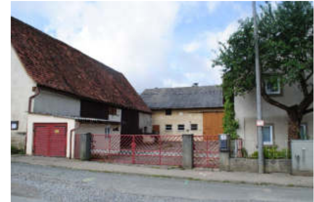
Abb. 119 – Ostansicht der Hofstelle
