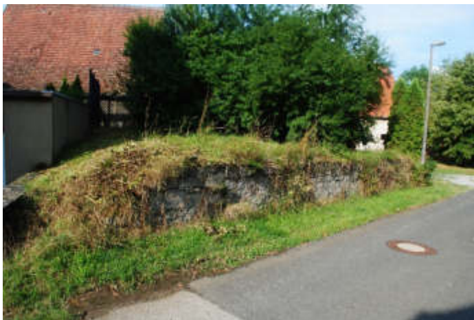
Abb. 080 – Uffenheimer Weg Fl.-Nr. 39 – Mauerzug nach Abriss
