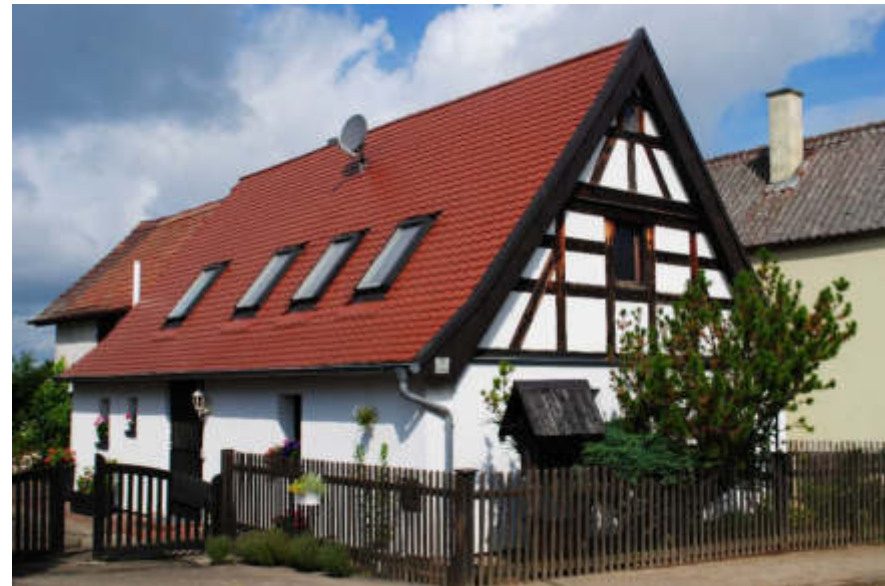
Abb. 118 – Südostansicht – Fachwerk teilweise erneuert
