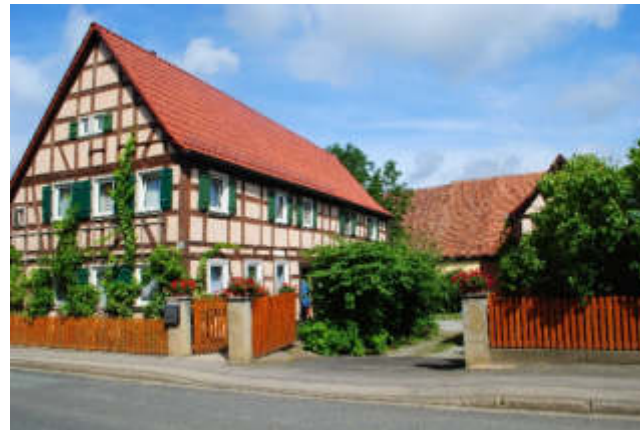
Abb. 138 – Hofstelle von Südosten
