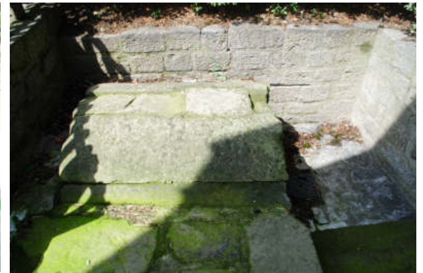
Abb. 173 – Brunnenhaus mit Verdachung und Einfassung - Seitenansicht
